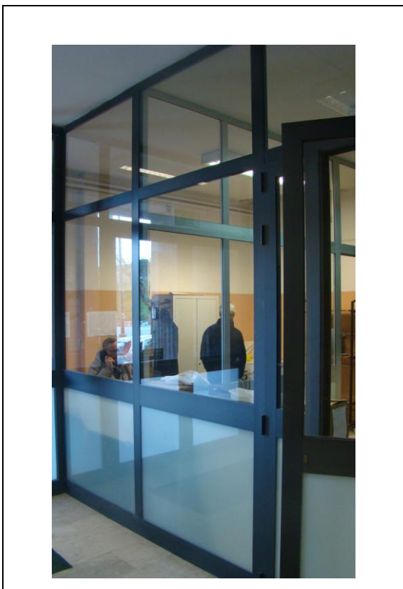
Ingresso: portineria da sostituire.
