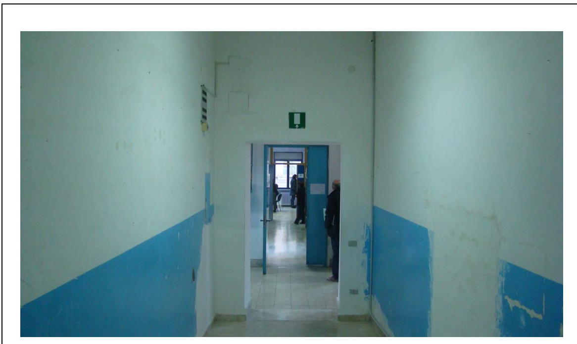
Primo piano: corridoio della segreteria da consolidare visto dalla nuova ala.
