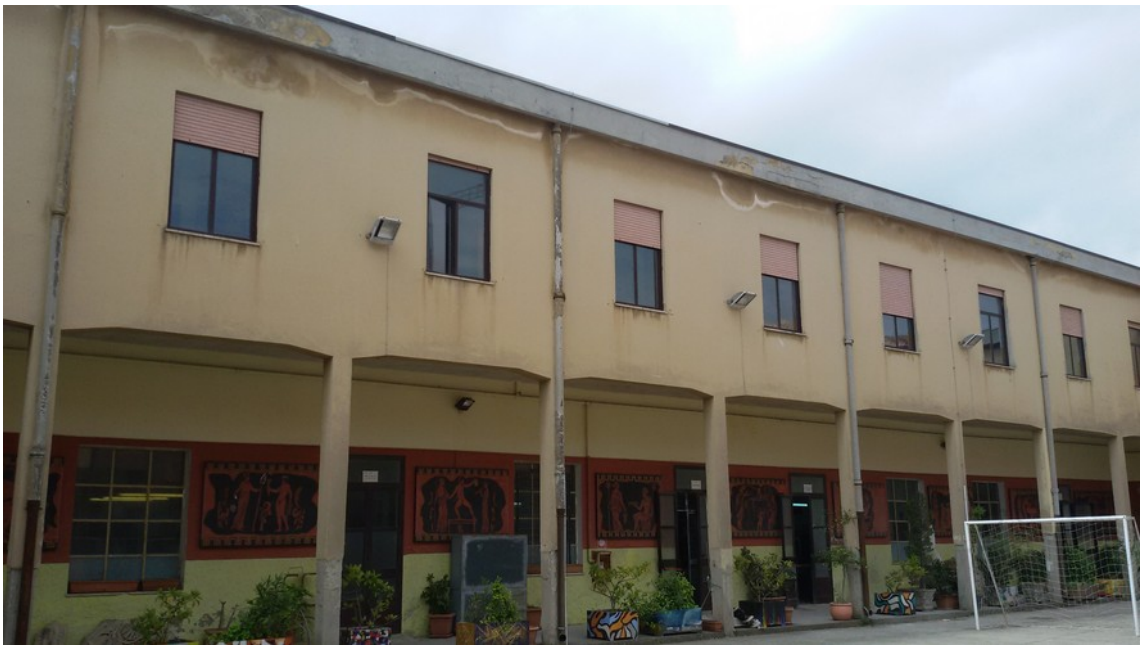
Veduta cortile interno
