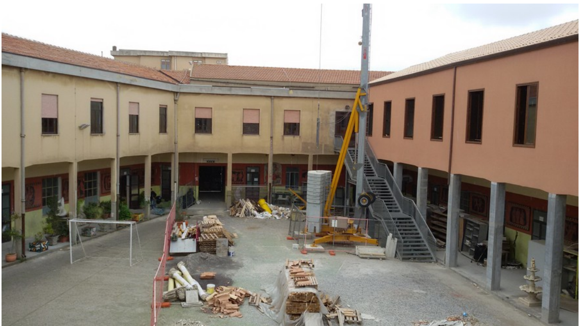
Veduta cortile interno
